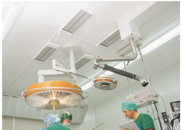
Utilizar paneles radiantes EZ200 para calentar una estancia resulta extremadamente higiénico, ya que no provocan ningún movimiento de aire.
