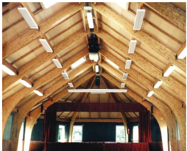
El EZ200 proporciona calor instantáneo sin precalentamiento, por lo que resulta ideal para edificios que no se utilizan con regularidad.
